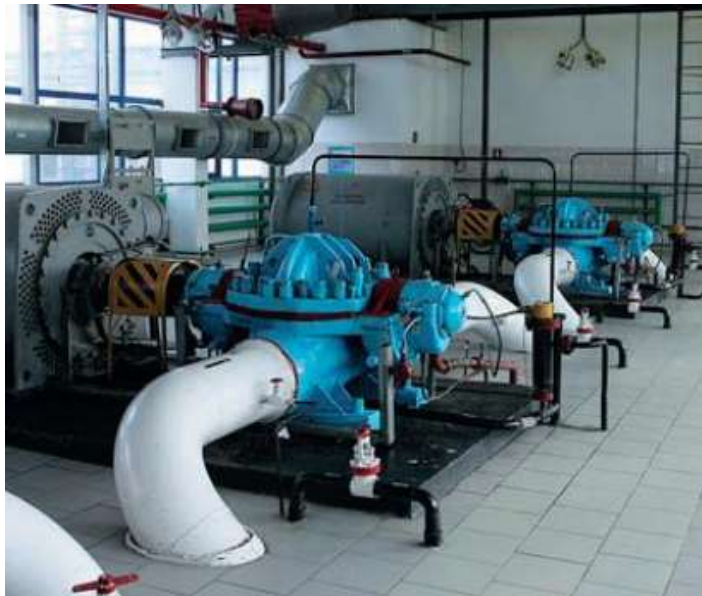
Рисунок 2.5- Насосный агрегат с насосом ряда НМП (начало)
