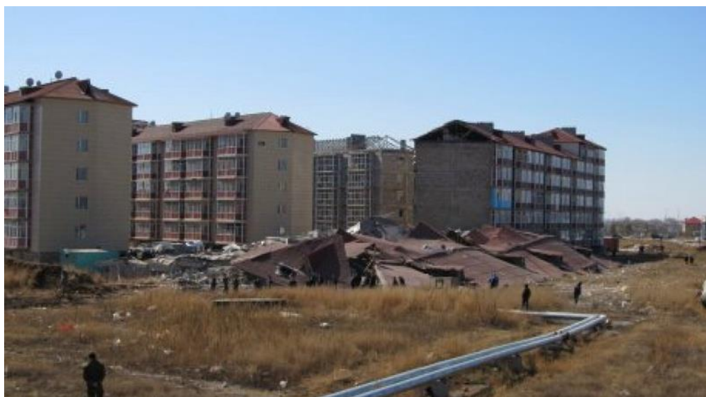
Рисунок 3.3 – Обрушение жилого комплекса «Бесоба»
