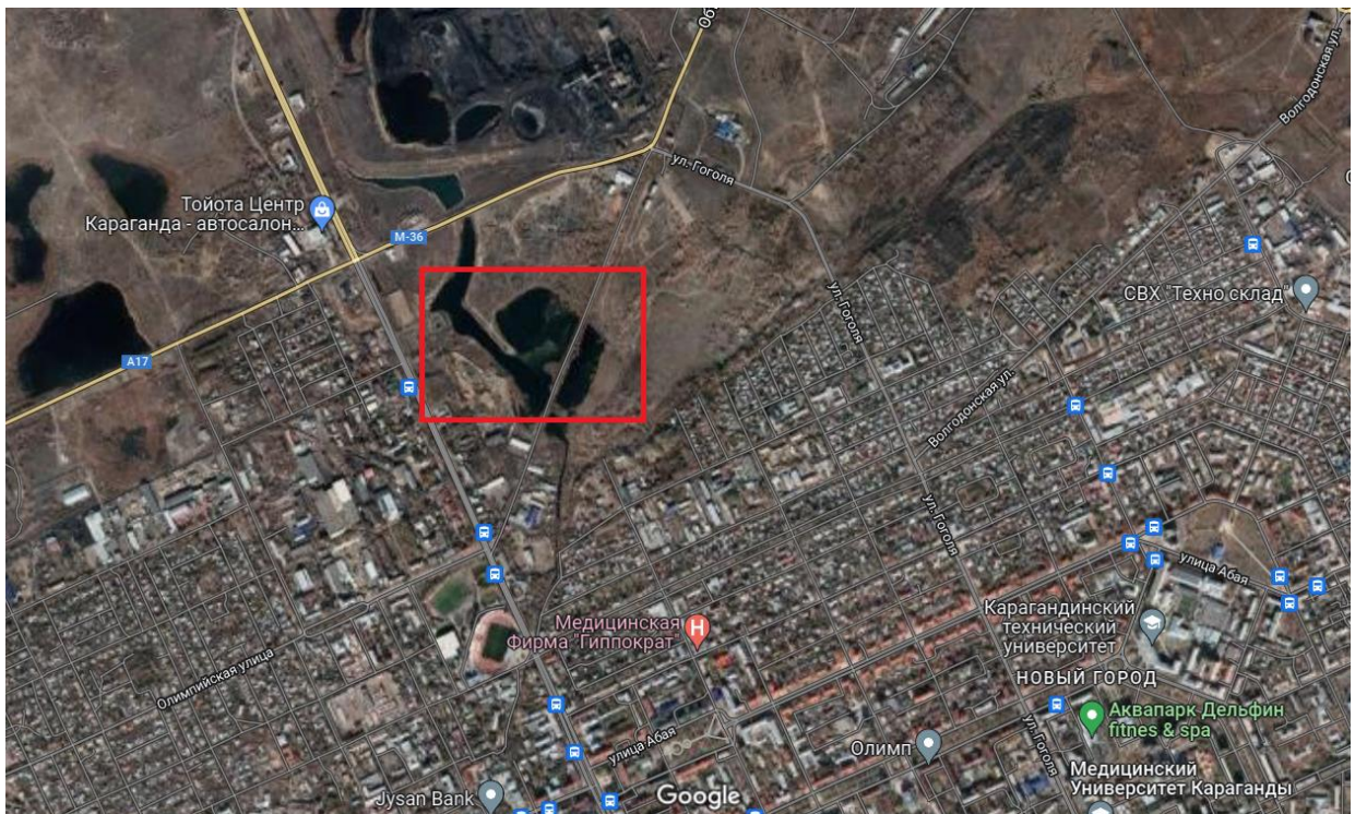
Рисунок 3.8 – Месторасположение котлована по ул.Новгородская
